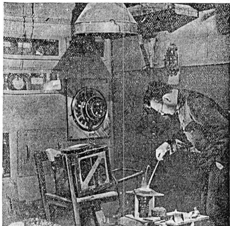
За последние годы лаборатория электрометаллургии разработала для промышленности очень много важных тем. Здесь разработаны новые методы получения феррованадия и других ферросплавов, исследованы новые методы плавки нержавеющей стали и др. НА СНИМКЕ: высокочастотная установка в лаборатории электрометаллургии.
