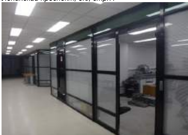
Рисунок 15. Капитальный ремонт помещений «Точка рождения инноваций» по адресу: Ленинский проспект, д.6, стр.7.
