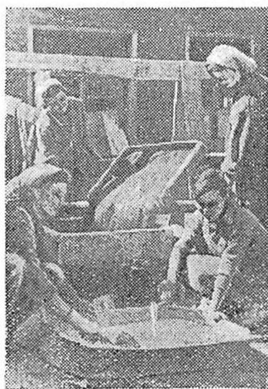
НА СНИМКЕ: студенты гр. М-41-31 бригады тов. С. Негримовского на ремонте толмачевского общежития.
