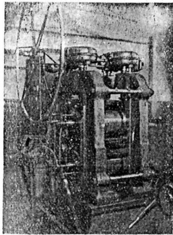
Шестивалковый ленточный прокатный стан, установленный в лаборатории прокатки в 1937 году.
