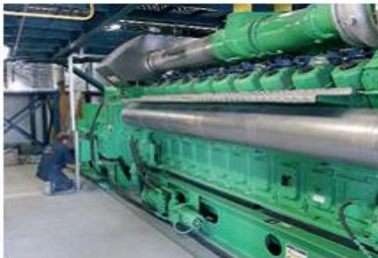
*Рис.4.13. - Газопоршневой агрегат JMS 620 GSN.LC*
