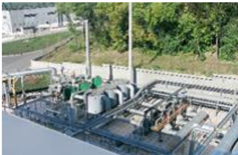
*Рис.4.17. - Площадка подготовки газа для газопоршневых агрегатов*
