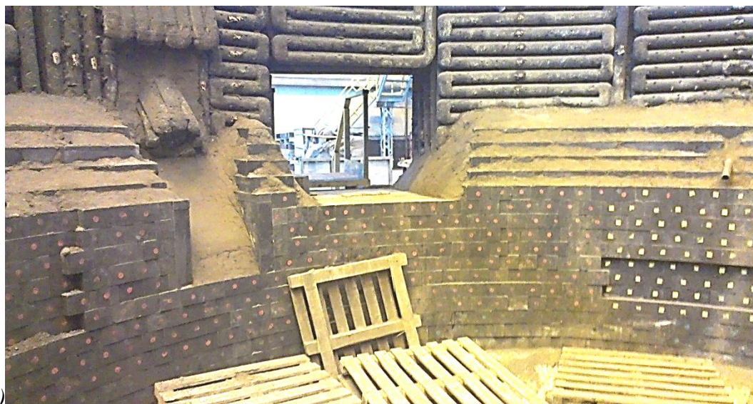
Рис.2.3. Состояние футеровки ДСП-150 после монтажа рабочего слоя стен (вид изнутри) и установки водоохлаждаемых панелей: а–вид на эркерную зону, б – вид на рабочее окно.
