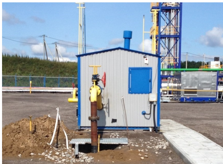
Рисунок 2.27 – Узел ввода газа
