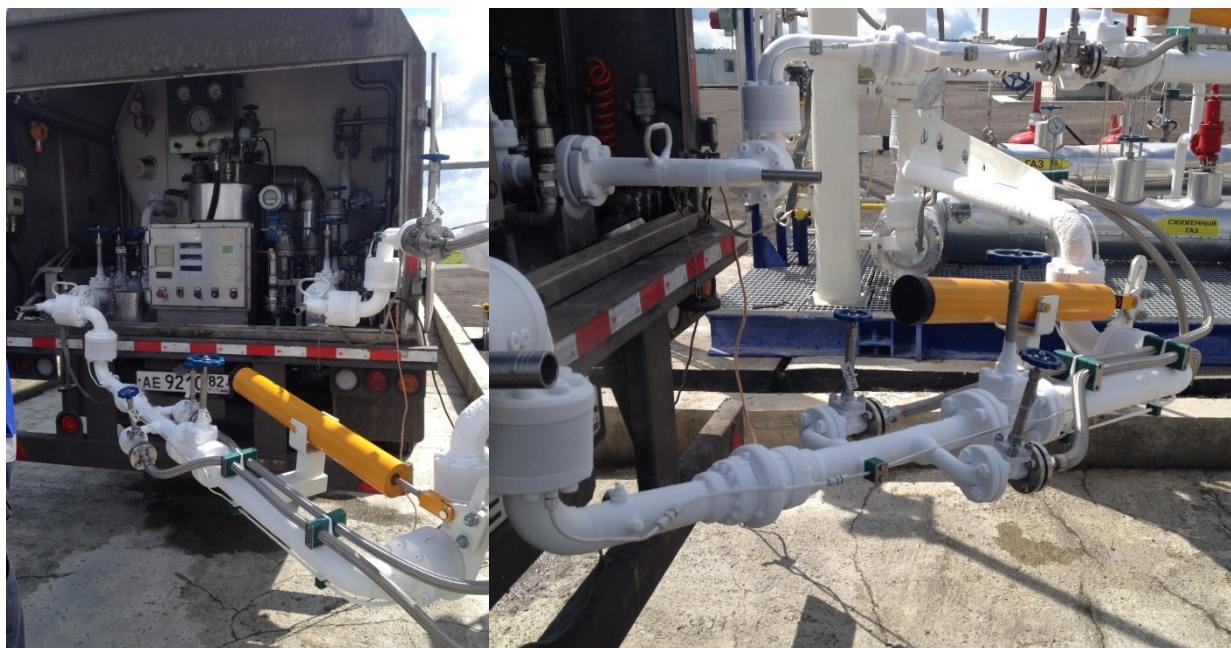
Рисунок 2.31 – Процесс заправки автовоза СПГ
