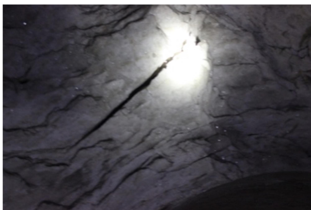
Рисунок 1.4 – Растрескивание в своде очистной выработки [9]
