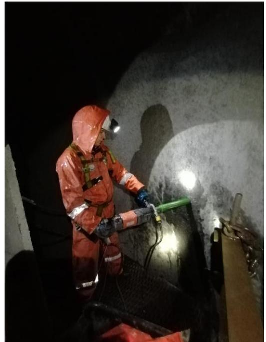
Рисунок 3.3.2.1 – Установка алмазного бурения Messer DM-130 и процесс отбора керна в стволе
