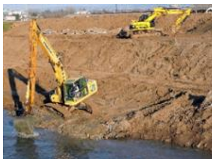
Рисунок 1.6 – Использование экскаваторов для освоения залежей прибрежных зон
