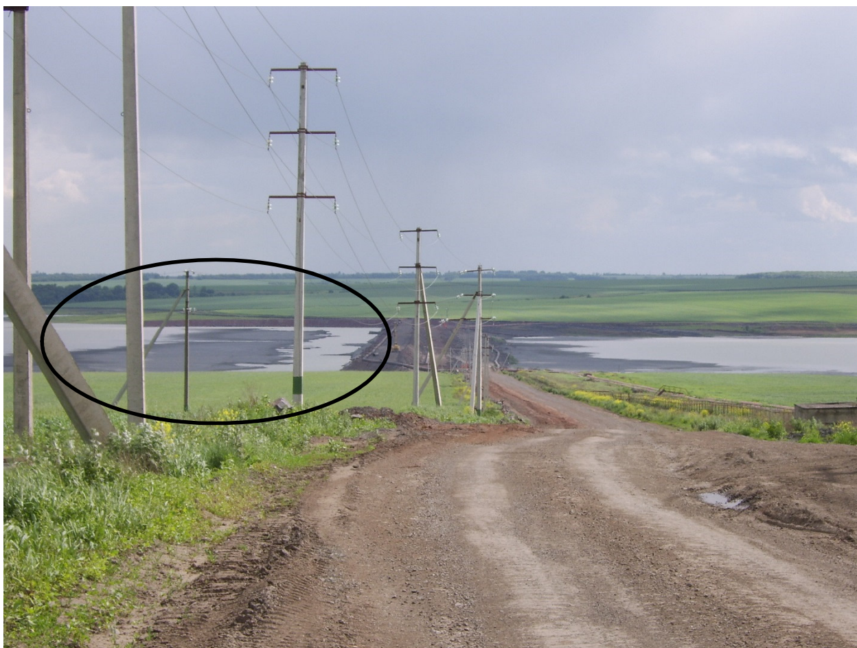
Рисунок 3.2.5 – Формирование хвостохранилища с намывом острова на удалении от дамбы (выделенная часть фото)
