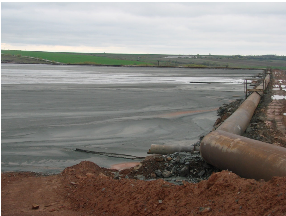
Рисунок 3.1.2 – Сухие пляжи на границе с оградительной дамбой
