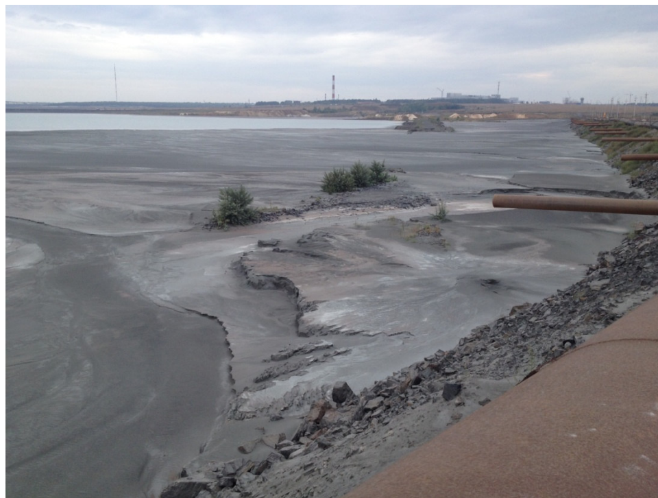
Рисунок 1.2.1 – Пример скопления илистых составляющих перед дамбой
