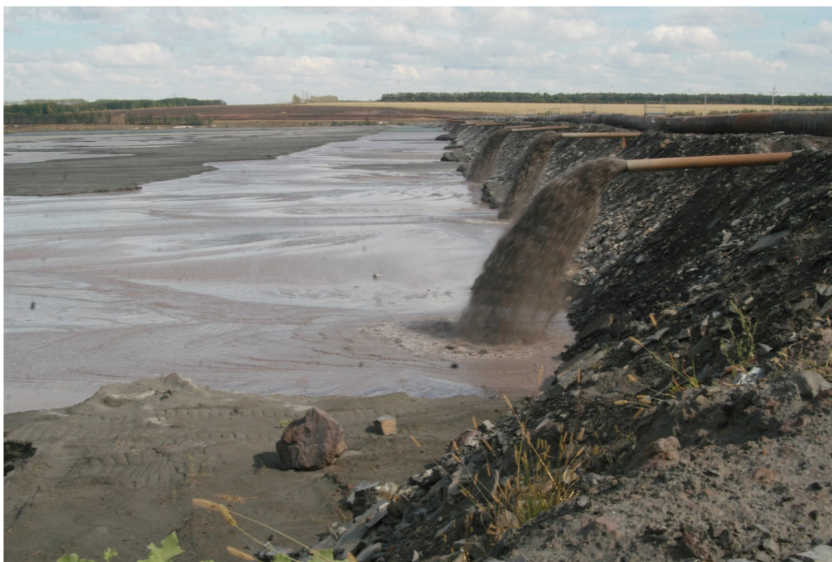
Рисунок 3.1.1 – Береговая часть хвостохранилища с распределительными пульпопроводами
