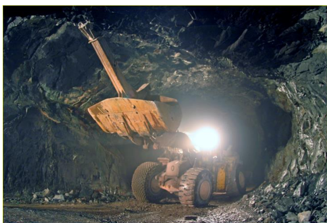
Рисунок 3.9 – Обезопасивание кровли установкой ОКНТ
