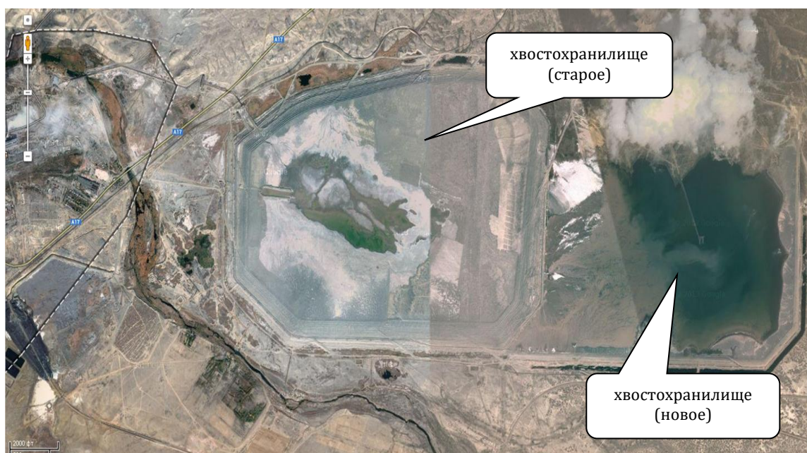
Рисунок 5.1 – Общий вид на хвостохранилище №1 ЖОФ в плане
