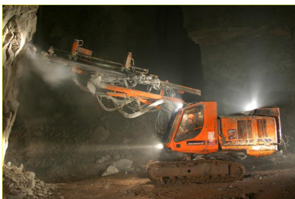
Рисунок 3.6 – Бурение вееров скважин в МКЦ установкой Ranger
