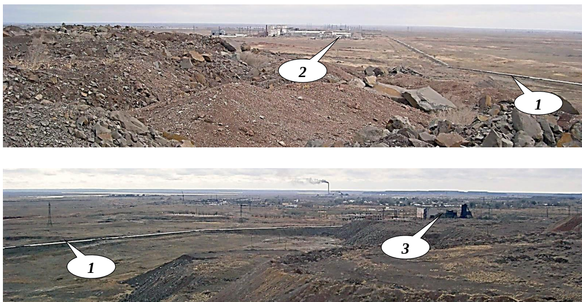
Рисунок 3.28 – Вид закладочного пульпопровода (1) от Сатпаевской ОФ (2) к Анненскому закладочному комплексу (3)
